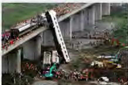
高速鉄道が脱線し落下した事故現場。一 夜明け、地上では重機で車両(右下)を埋 める作業が続いていた=24日午前8時18分、中 国浙江省温州、嵯山昇生撮影
